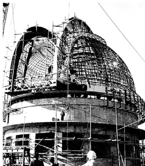
けんせつちゅう はんしゃほうえんきょう 建設中の188cm反射望遠鏡ドーム ていきょう こくりつてんもんだい おかやまてんたいぶつりかんそくしよ 提供:国立天文台 岡山天体物理観測所
