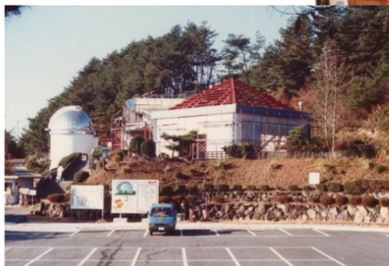
プラネタリウム建設中
