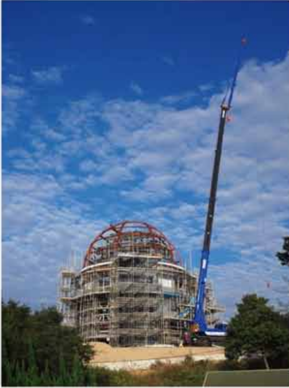
建設中のせいめい望遠鏡ドーム
